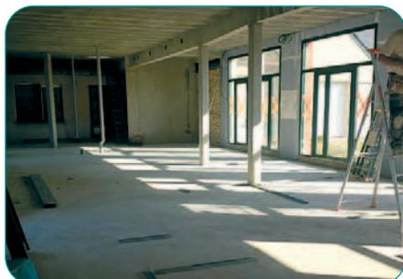
Après dix mois de travaux dans la première phase d'extension et de réhabilitation de la structure, le bâtiment est enfin hors d'eau et hors d'air, les lots de second œuvre (isolation, plomberie, électricité...) vont pouvoir débuter. L'appartement témoin doit être livré pour fin juillet.
