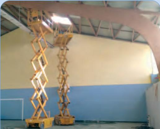
La reprise de la charpente (doublage des pannes, reprise contreventement et remplacement de pièces abimées par les gouttières) demande un peu d'audace et de moyen matériel.
