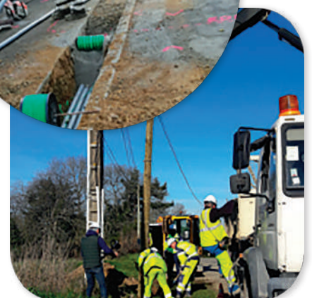
Pose d'un nouveau support
